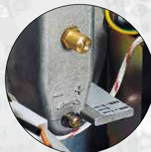
Регулировка головки горения
